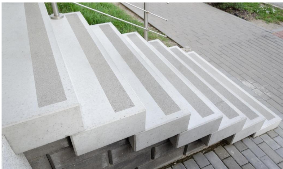
Obr 5. – Schodišťové bloky - realizace
