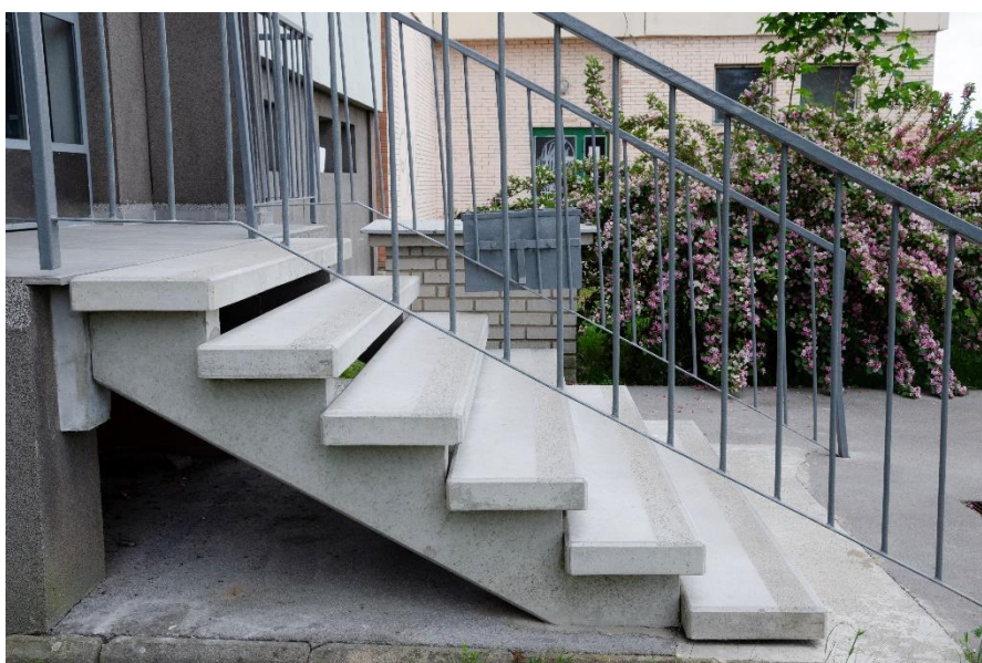
Obr 4. – Schodišťové desky - realizace
