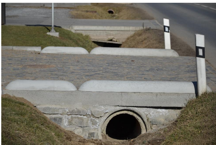
Obr. 8 – Realizace – zábrany pod kola
