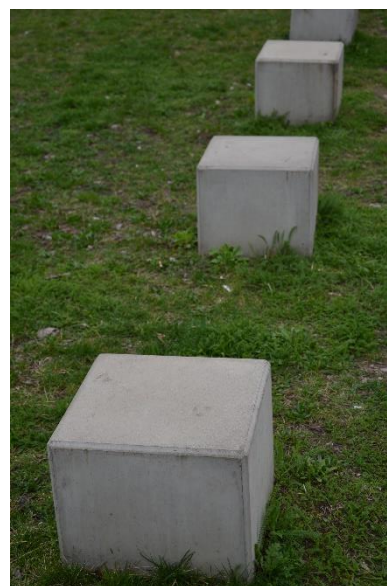
Obr. 9 – Realizace – zábrany kostky
