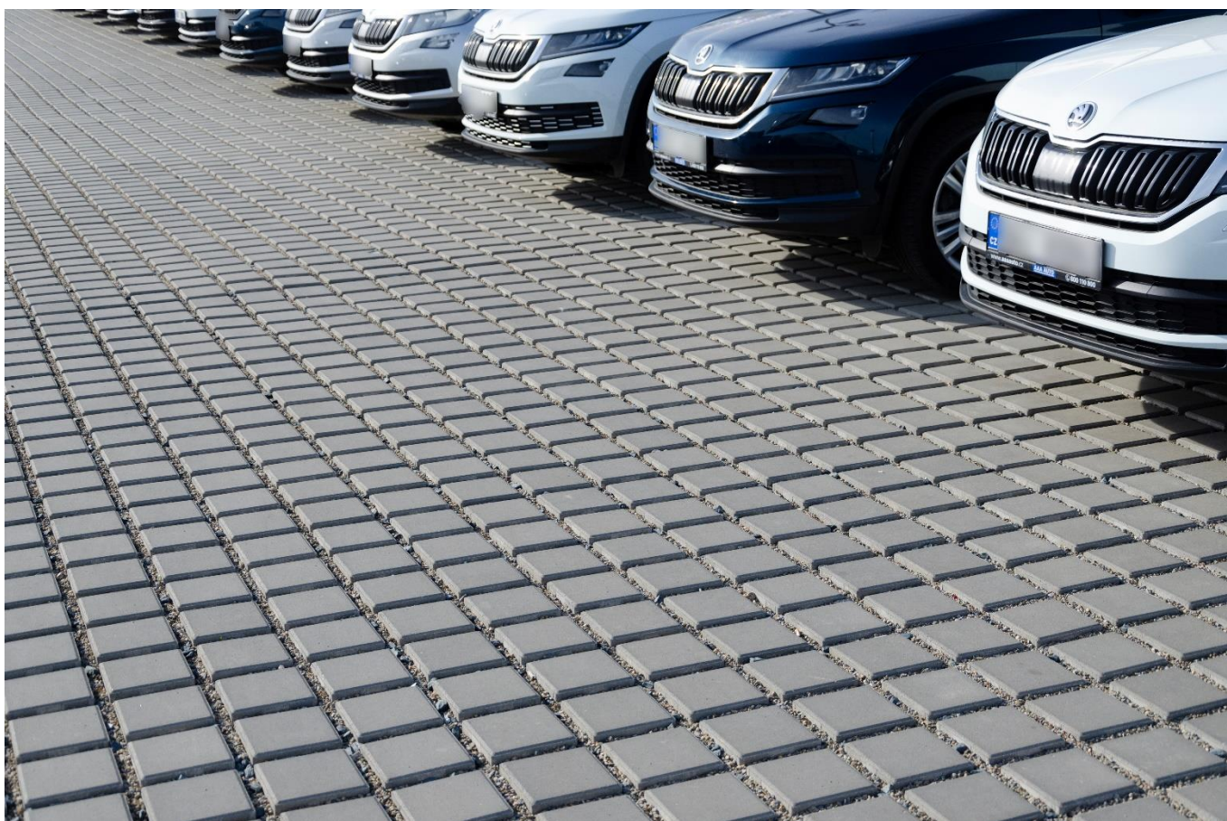
Obr 10. Příklad realizace pokládky vsakovací dlažby LORA
