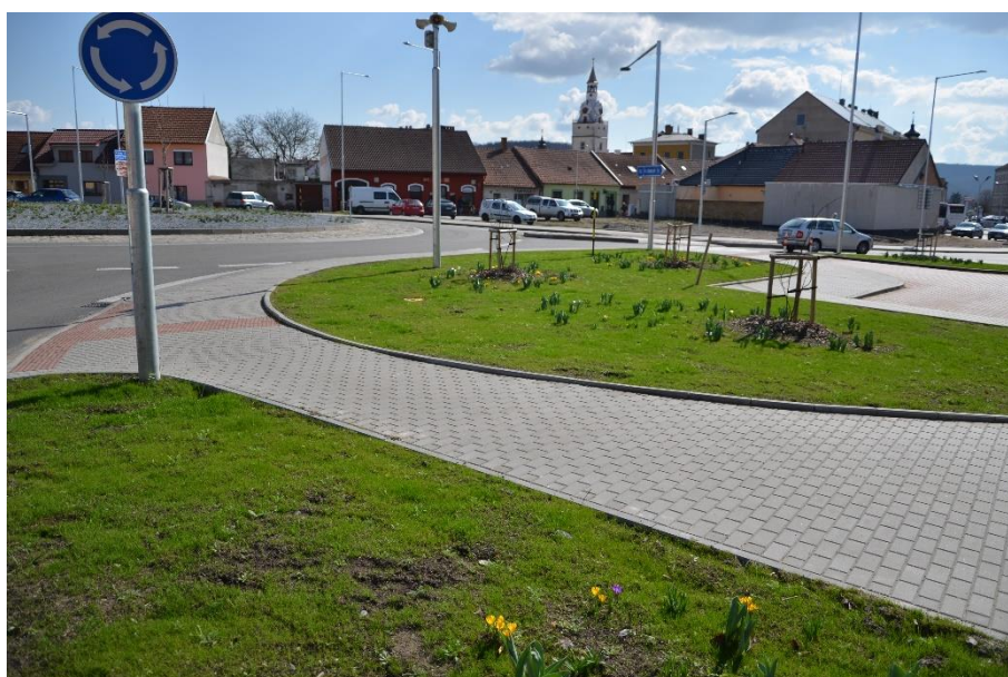
Obr 4. Příklad realizace pokládek betonových dlažebních prvků a obrub
